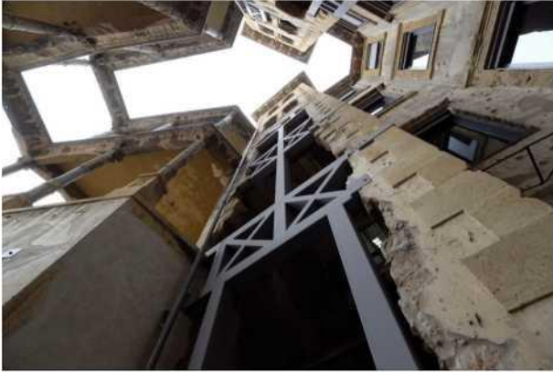
ベイト・ベイルート、または「ベイルートの家」。1924年に建てられたこの建物は、内戦で一部が破壊されました。現在は博物館として保存され、戦争を告げる長い記憶の歴史の一部として残すことを試みている。著作権者
